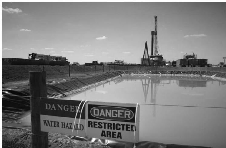
Figura 3. Pozo de SG en Pennsylvania
